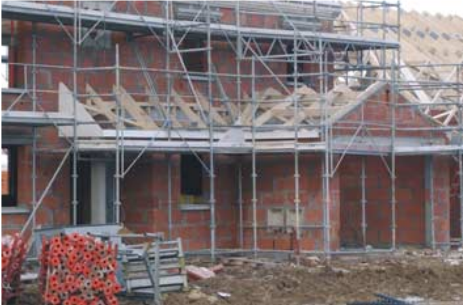
Figure 3. Échafaudage de pied
